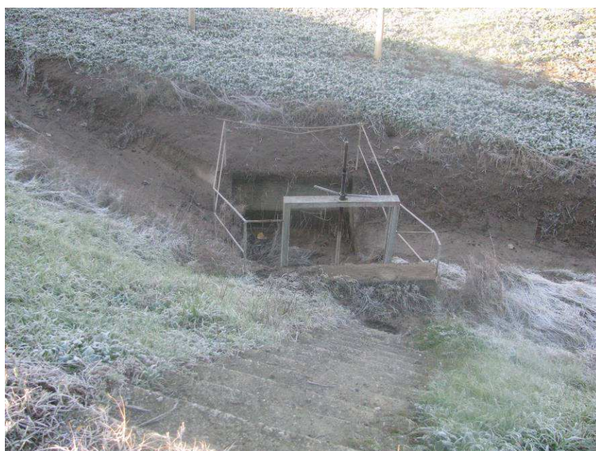
TRATTO A-B: chiusa all'innesto con l'argine preesistente sommersa; livello Fiume Bormida a -2,35 da testa argine.
