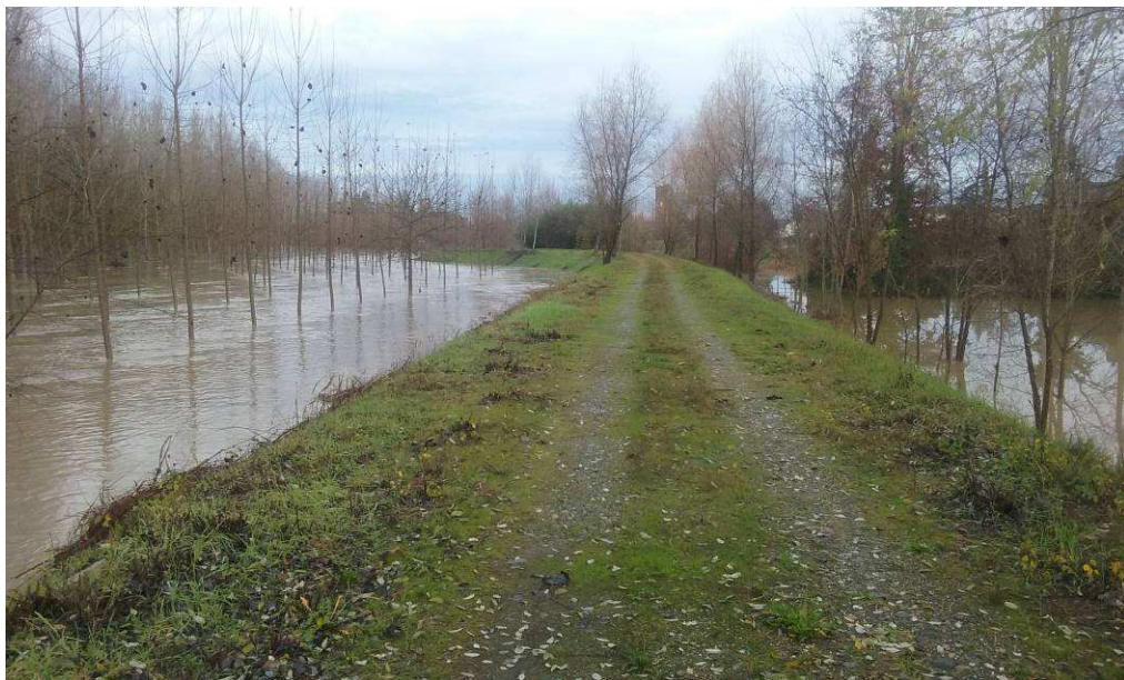
TRATTO A-B: area di esondazione per fosso a cielo aperto a destra e a sinistra livello Fiume Bormida a -1,65 da testa argine.
