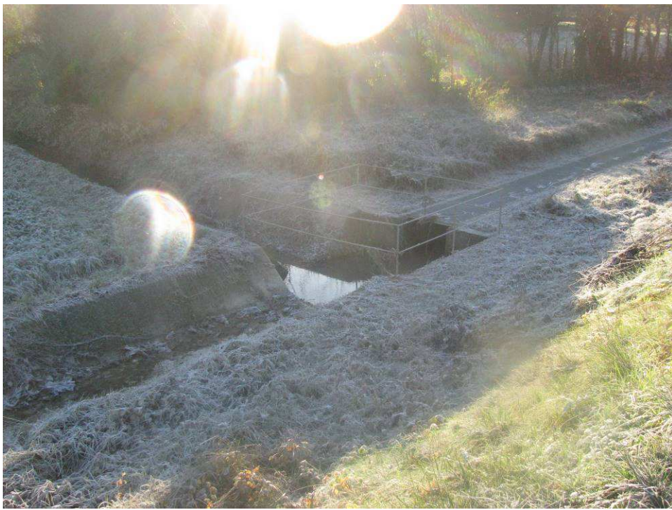
TRATTO A-B: area di esondazione per fosso a cielo aperto in corrispondenza del manufatto di imbocco del canale in contropendenza attorno all'argine; vista dal camminamento in testa all'argine dopo lo smaltimento del fosso a piena rientrata.
